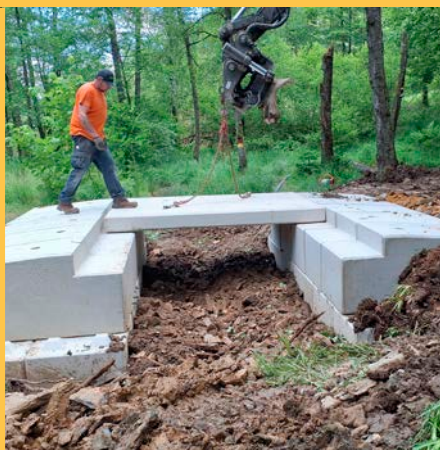
7. Pose du tablier. Les dalles sont dimensionnées pour le passage des charrois lourds.
