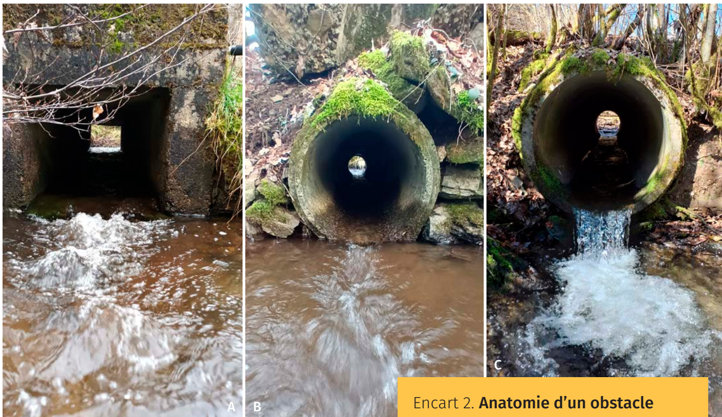
Photo 2. Les ouvrages de franchissement de voirie « en cadre fermé » (buses, pertuis...) peuvent constituer des obstacles sérieux à la migration des poissons.
