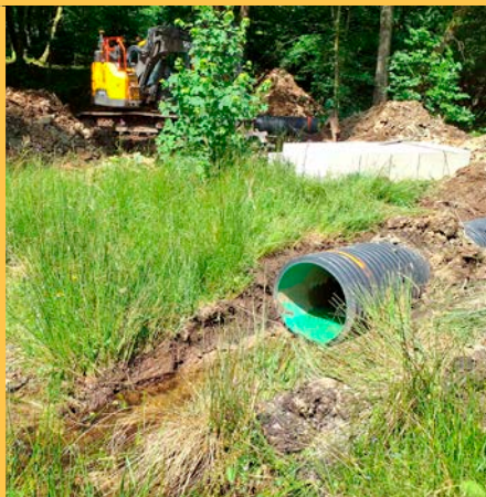
2. Batardeau. Le cours d'eau est d'abord dévié et l'ouvrage mis à sec pour éviter tout impact durant les travaux.
