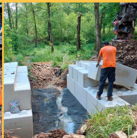
5. Montage des culées. L'assemblage se fait à sec, selon le principe du célèbre jeu de construction.
