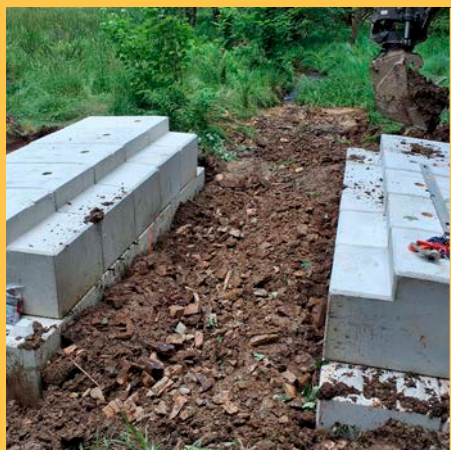
6. Reconstitution du lit. Remblaiement entre les culées avec un matériau adapté suivant la pente naturelle.
