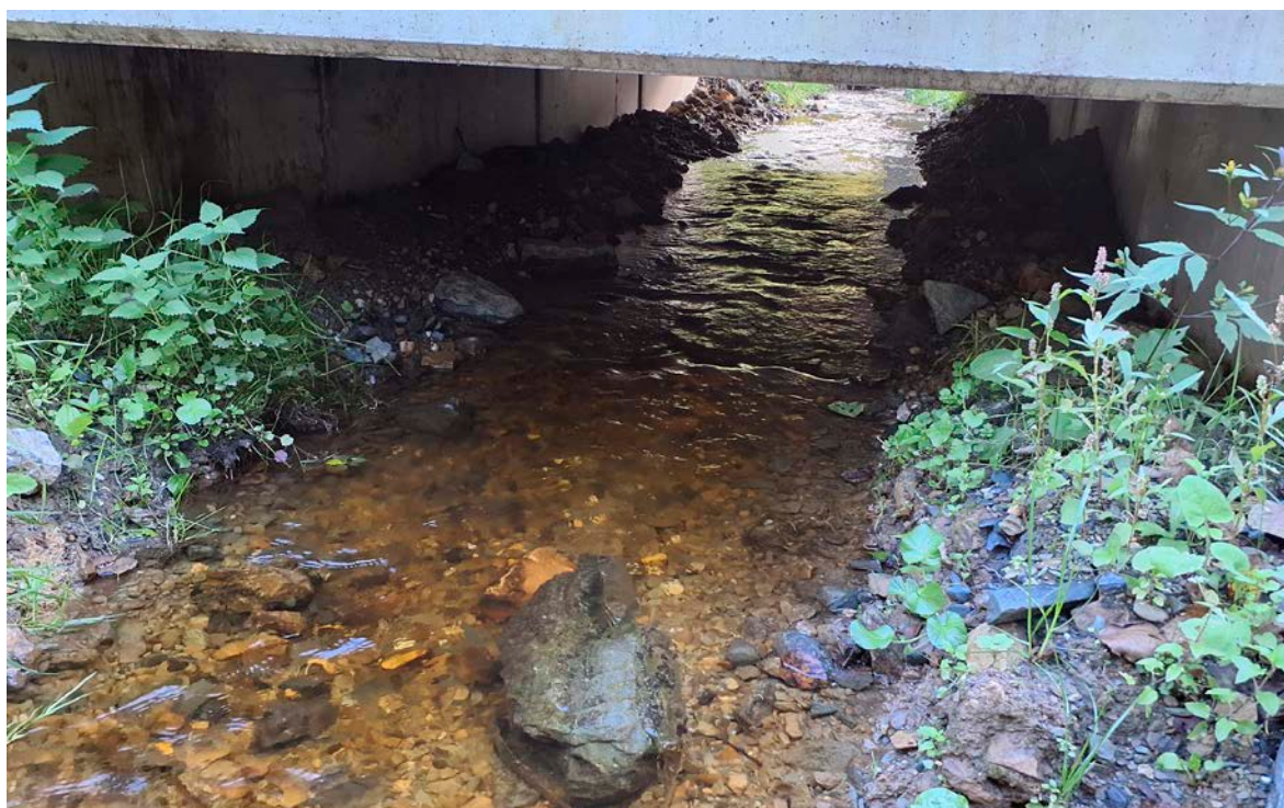
Photo 4. Le lit naturel du cours d'eau est préservé sous l'ouvrage.
