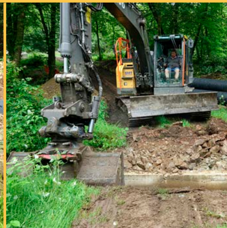
3. Démolition. L'ancien ouvrage est supprimé et les débris évacués.
