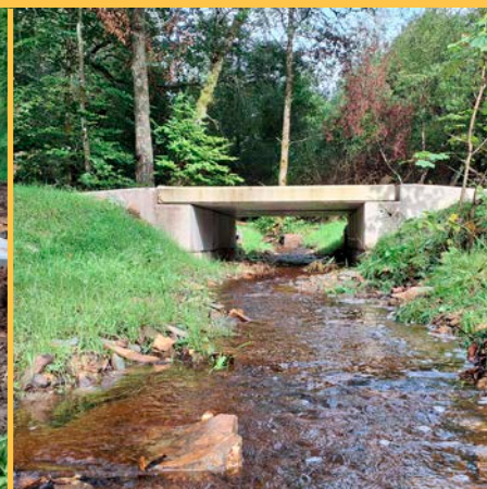
8. Mise en eau. Sous le nouveau ponceau, la rivière libérée retrouve un lit naturel.
