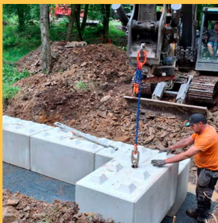
5. Montage des culées. L'assemblage se fait à sec, selon le principe du célèbre jeu de construction.
