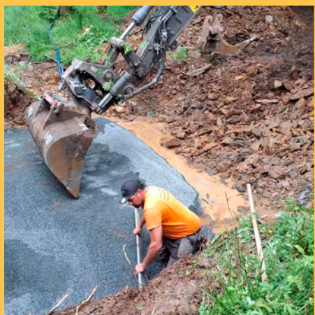
4. Lit de pose. Mise à niveau d'un lit de grenailles pour la pose des culées.
