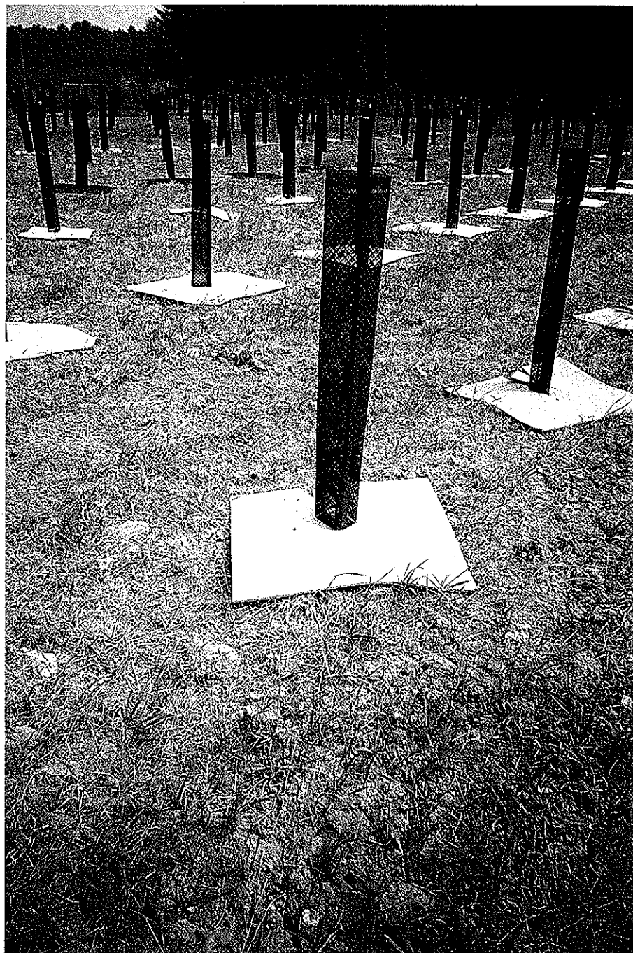
Préparation du sol et installation de dalles de paillage individuelles (à l'avant-plan des dalles de lièges, derrière des dalles de fibres de peupliers et de résineux).
