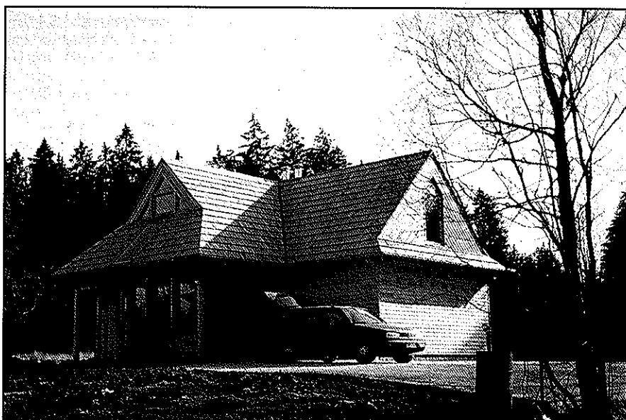
La maison forestière de Jalhay primée lors du concours «Habitat Bois» de 1994.
