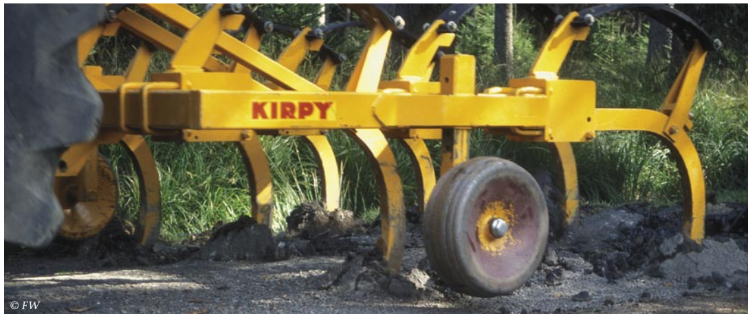
Photo 3 – La bande de roulage est défoncée en deux ou trois passages de chisel.
