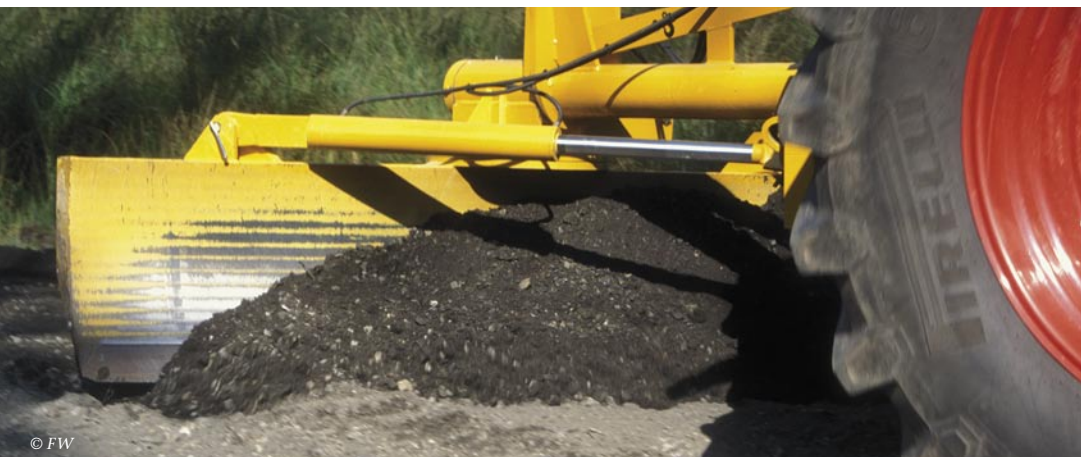
Photo 5 – La lame, à commandes hydrauliques, permet à l'entrepreneur de profiler soigneusement la route.
