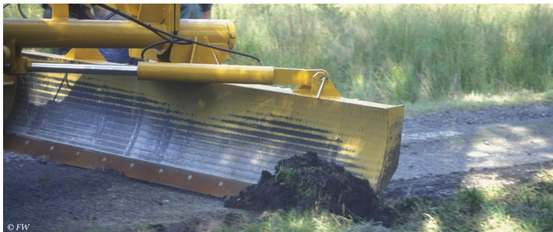
Photo 2 – L'entrepreneur rafraîchit les limites de la route avec la lame afin d'éviter d'incorporer trop de matière organique à la nouvelle assise.
