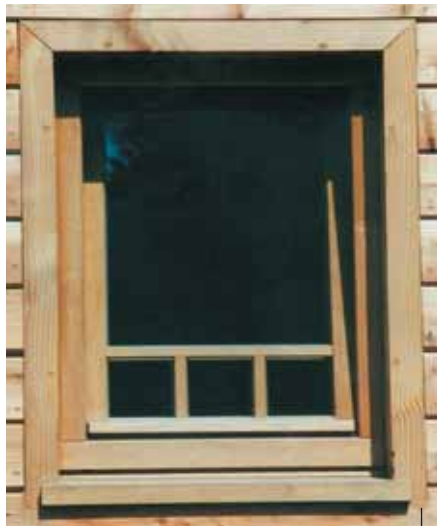
Fenêtre d'une maison en ossature bois à Uccle, architecte Francine Henrotte.
