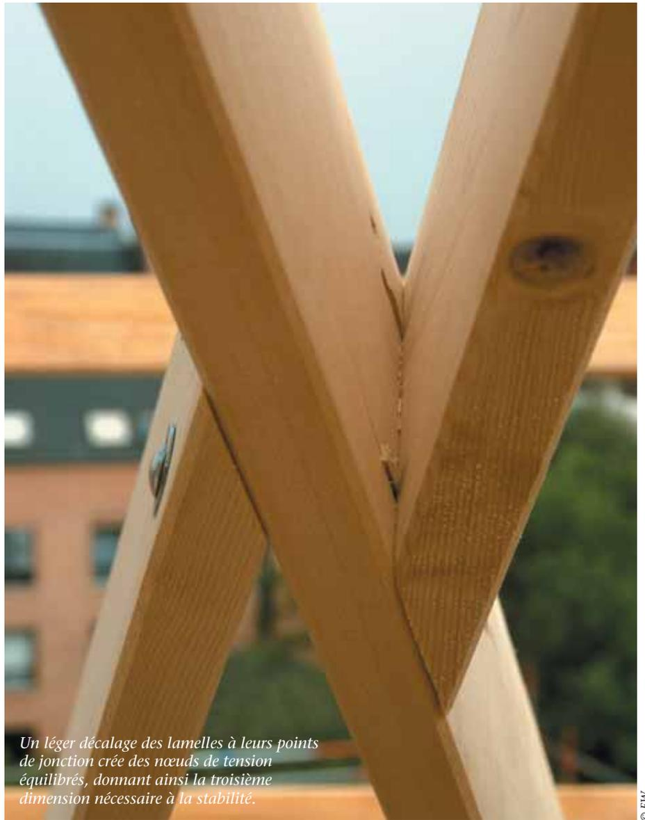
*Un léger décalage des lamelles à leurs points de jonction crée des nœuds de tension équilibrés, donnant ainsi la troisième dimension nécessaire à la stabilité.*
