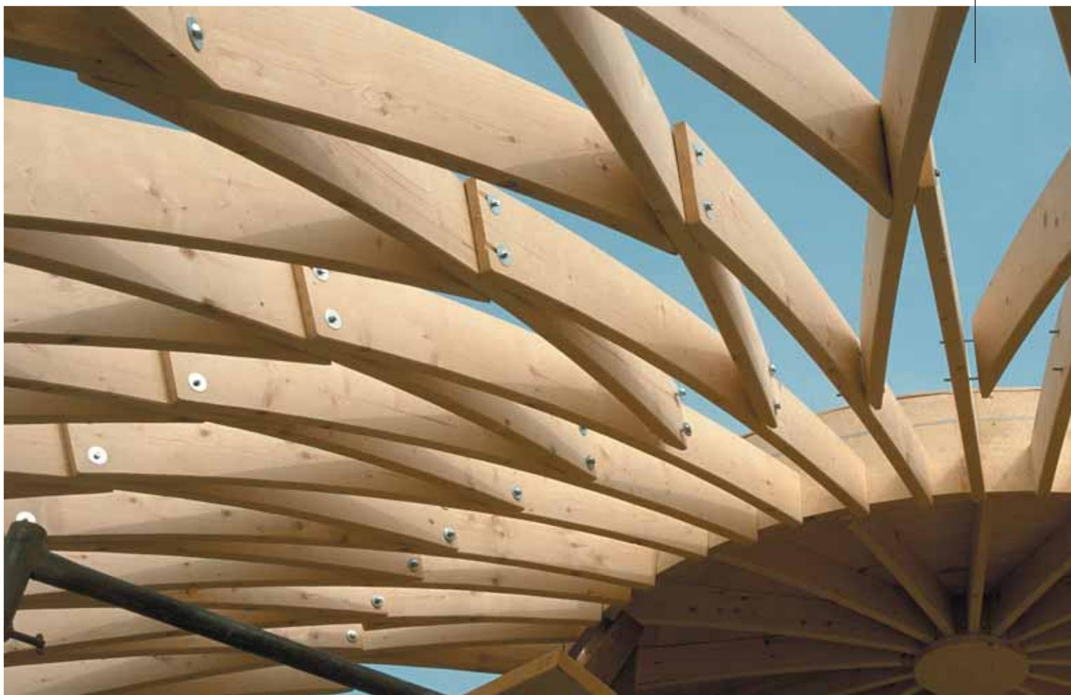
ci réalisait ses charpentes en peuplier afin de diminuer les coûts de production. Il se fournissait en déchets sur les chantiers navals où le peuplier entrait dans la fabrication des cales de bateau. Le génie de Philibert de L'Orme se situe là : l'assemblage de tous ces petits bouts de bois, apparemment sans plus aucune valeur, afin d'en faire des charpentes.
