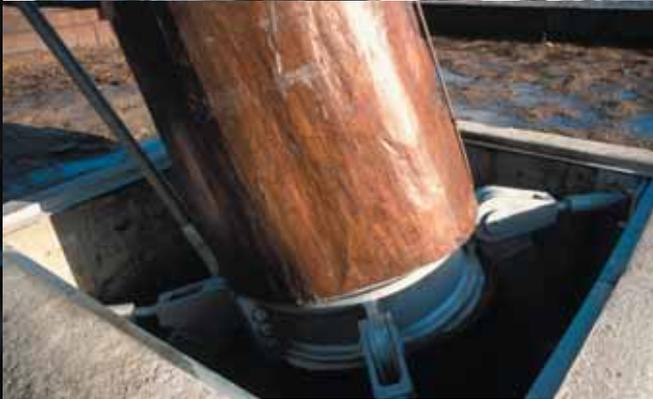
Les pieds de la tour ne sont pas enfoncés dans le sol afin d'éviter la dégradation du bois. Les piliers sont soutenus par des vérins, ce qui permet également de « redresser » la tour en cas de besoin. La structure en bois est en effet susceptible de travailler au cours du temps.
