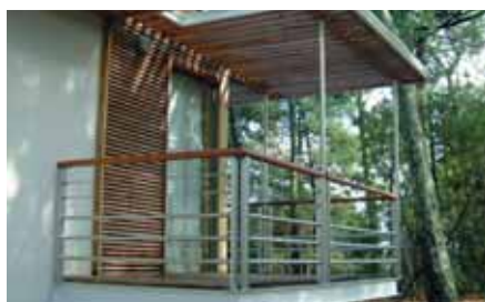
Bardage en Pin maritime au Cap Ferré. Une fois les persiennes posées, on aura l'impression d'une surface unie comme pour un séchoir à tabac.
