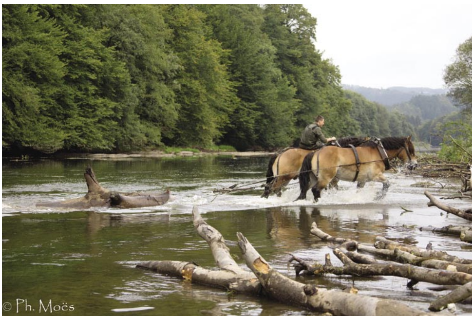
Figure 3 – Enlèvement d'embâcles sur la Semois.
