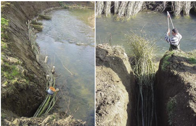
Installation d'épis et fascines de saule sur l'Eau d'Heure, à Pry-les-Walcourt.
