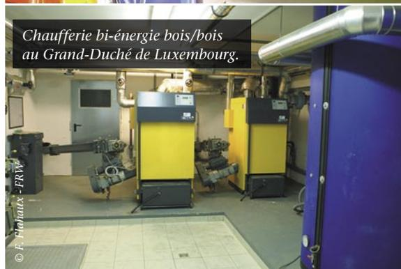
à des valeurs généralement comprises entre 40 et 70 % de la puissance totale nécessaire, tout en assurant un taux de couverture des besoins thermiques compris entre 80 et 90 %, voire plus, sur l'ensemble de la saison de chauffe.
