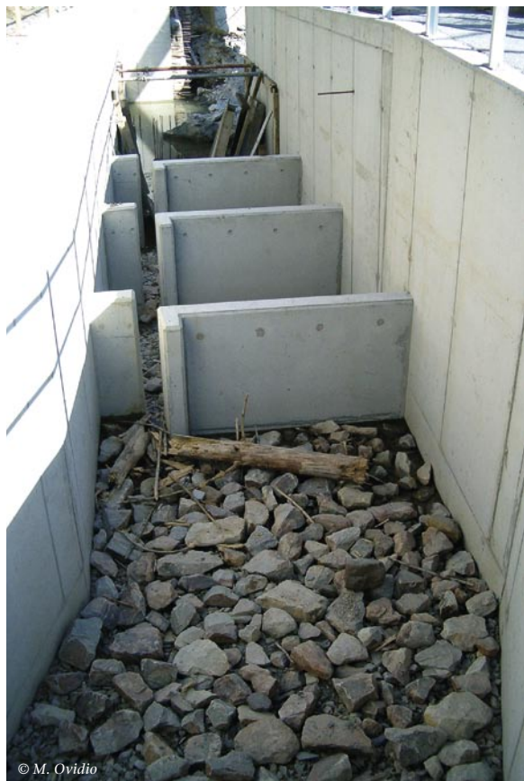
Figure 7 – Vue des bassins à sec de la nouvelle échelle à poissons de Lorcé sur l'Amblève. Les bassins sont équipés d'un substrat de fond pour permettre le passage des petites espèces benthiques de poisson (chabot, petite lamproie) et des macro-invertébrés.
