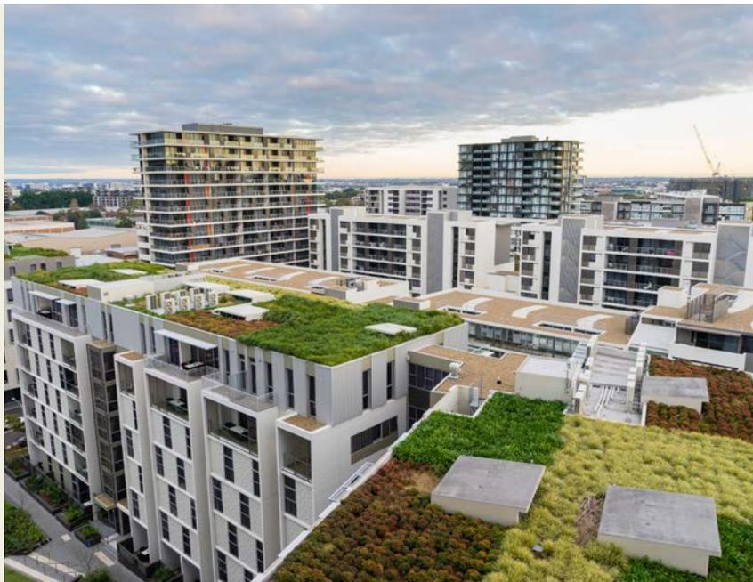
Par exemple, la mise en place de toitures végétalisées favorise une réduction substantielle des températures observées en milieu urbain, ce qui réduit les îlots de chaleur (figure 10).
