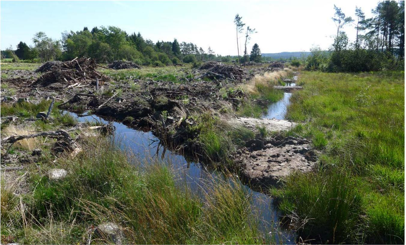
Plusieurs bouchons sont installés le long des drains afin de retenir au maximum l'eau sur les sites.
