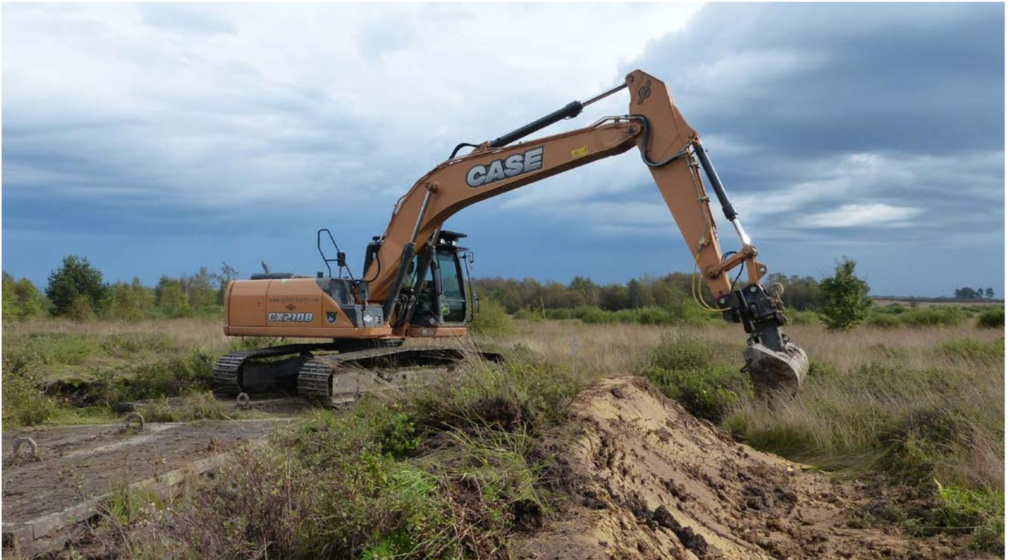
Création d'une digue d'envolement avec déplacement de la machine via plateformes afin de limiter le tassement.
