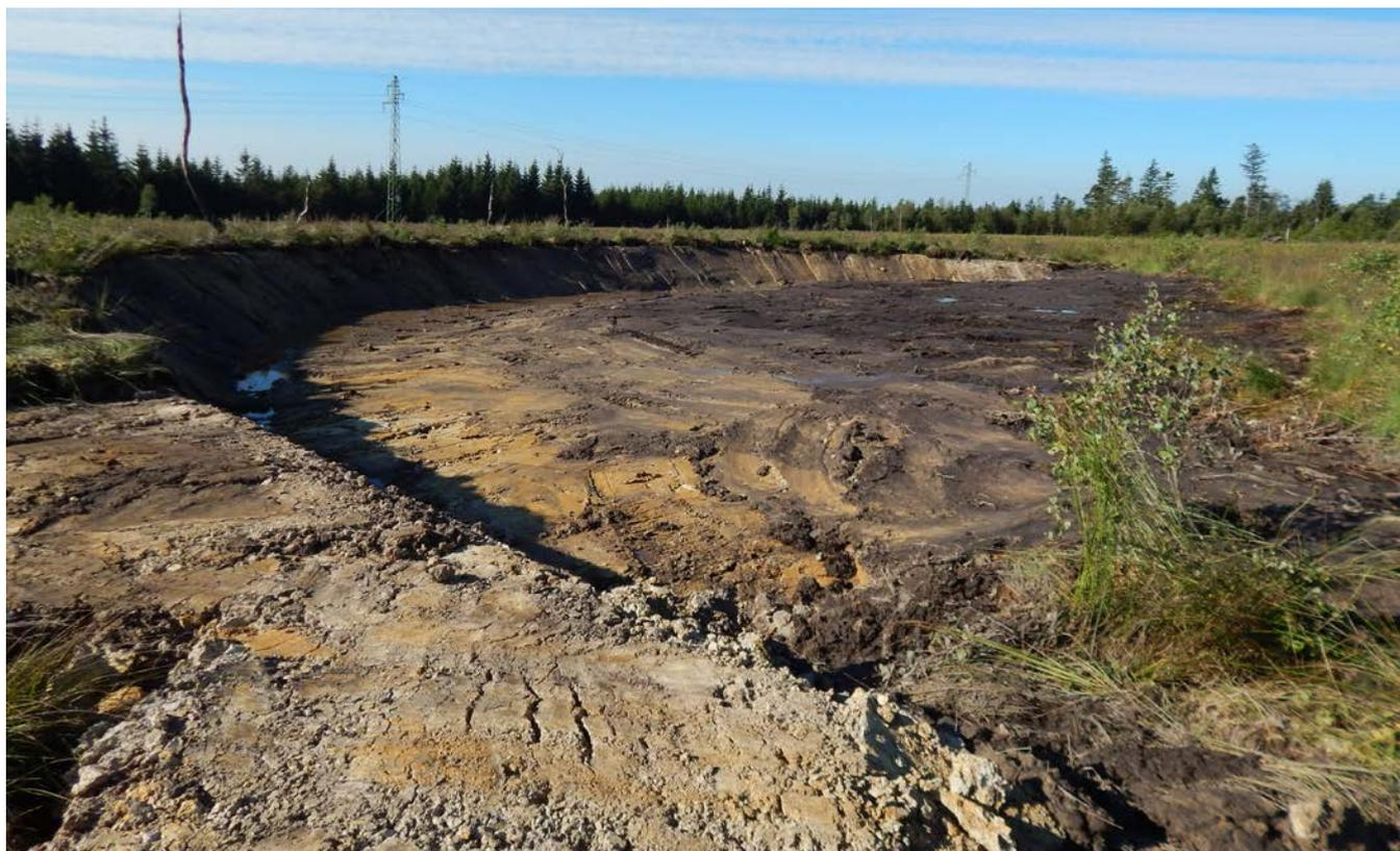
lever de l'argile et venir la plaquer sur le sol argileux dégagé précédemment. Petit à petit, une digue de plus ou moins 80 cm de hauteur se forme. Lorsque le « bourrelet d'argile » est érigé, il est recouvert avec de la tourbe et de la végétation prélevées lors du décapage et du creusement des trous, ceci accélère la végétalisation du rempart et permet de rendre ces formations moins visibles. Le barrage ainsi formé se remplit grâce à l'écoulement de l'eau de surface et aux précipitations.
