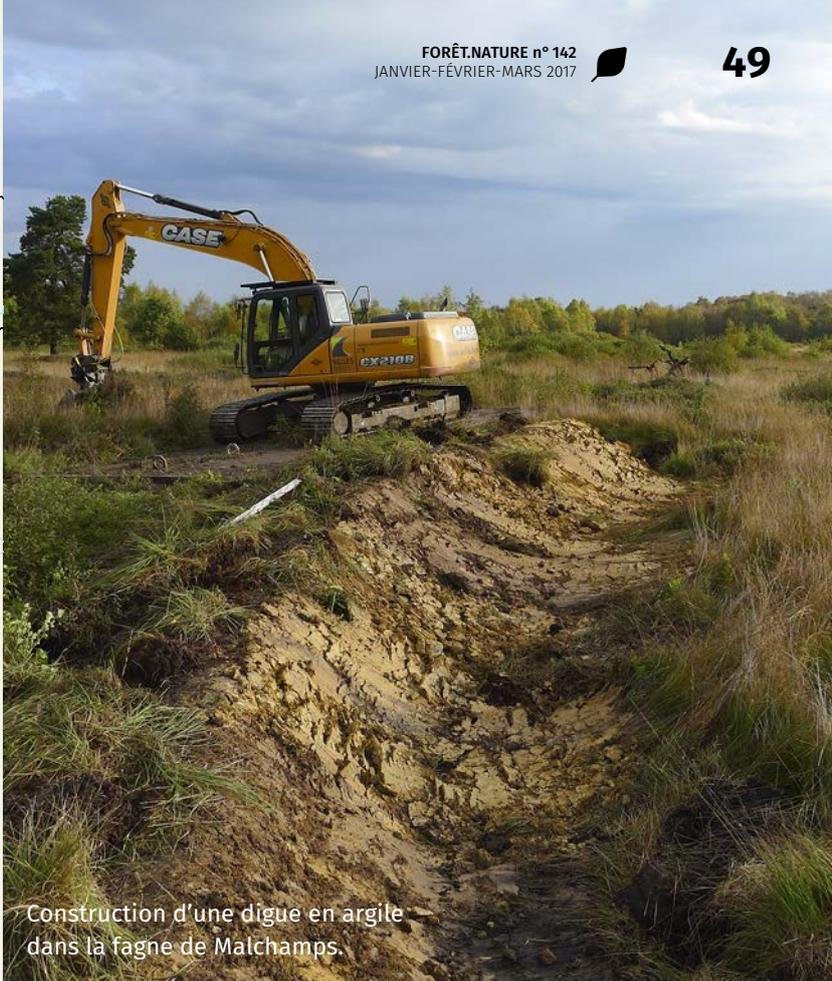
Construction d'une digue en argile dans la fagne de Malchamps.
