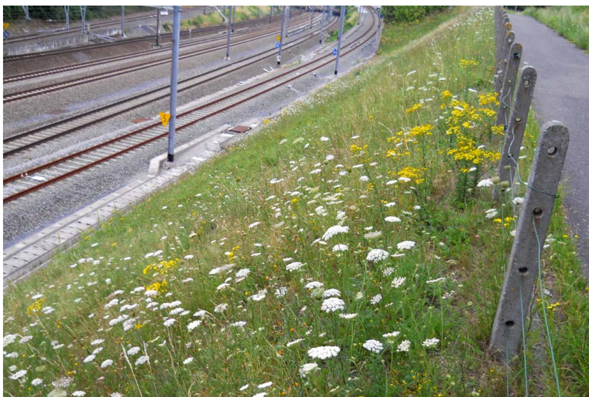
Aspect du talus près de la gare de Haeren en 2011 après prise en gestion.
