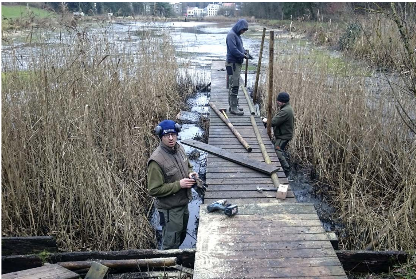
Aménagement par les éco-cantonniers d'un ponton d'observation au domaine des Silex.
