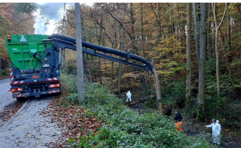
Photos 4 et 5. Mise en œuvre des mesures de réparation primaire dans l'écoulement situé entre les zones 2 et 3 : aspiration de la boue par un camion vacuum depuis la chaussée.
