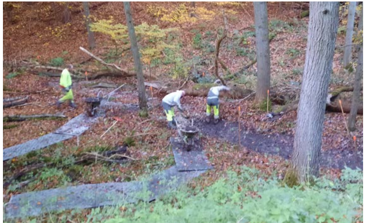
Photo 6. Mise en œuvre des mesures de réparation primaire dans l'écoulement entre les zones 2 et 3 : évacuation de la boue manuellement (à la pelle et à la brouette). Des plaques de roulage ont également été placées pour limiter l'impact des travaux de dépollution sur le site.
